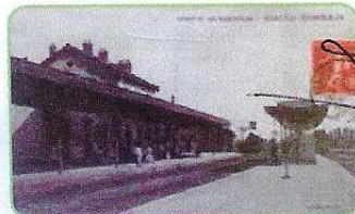
Flamboin, intérieur de la gare
